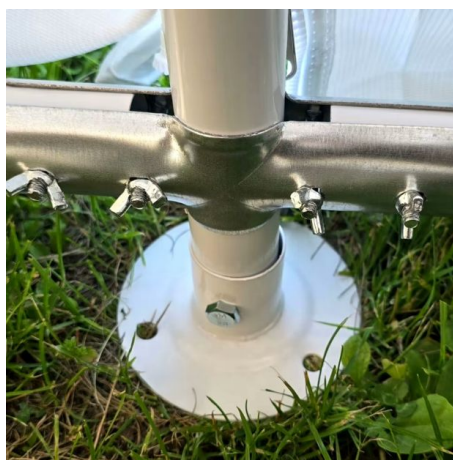
Jalaplaad avadega vaiade või ankrute jaoks
